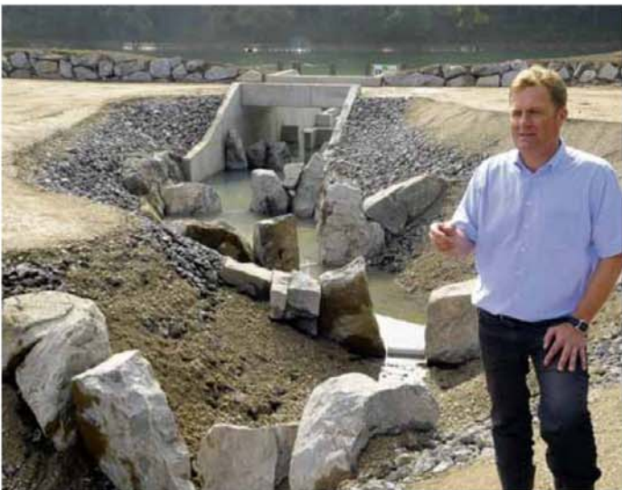
Baumaschinen haben an vier Iller-Kraftwerken Parallelgewässer geschaffen. Wenn sie eingewachsen sind, werden sie wie Bäche aussehen. Ziel ist es, dass die Fische wieder flussaufwärts wandern können. An der Iller wird in den nächsten Jahren Grundlagenforschung betrieben. Denn keiner weiß genau, was der richtige Fischschutz ist, sagt Ralf Klocke. Foto: Ulrich Wagner
