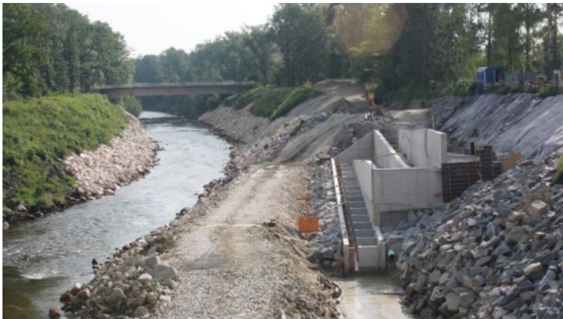
Am Ostufer der Wertach entsteht die Fischtreppe (im Bild links).
