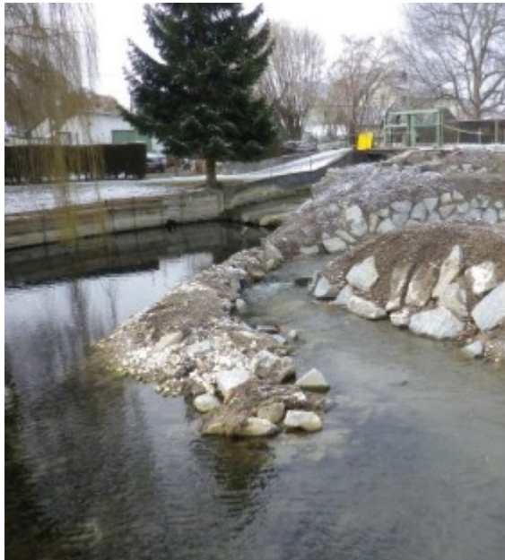
Das ist die neue Fischtreppe an der Singold am Eiswerk.
